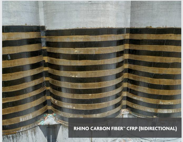
RHINO CARBON FIBER™ CFRP (BIDIRECTIONAL)
